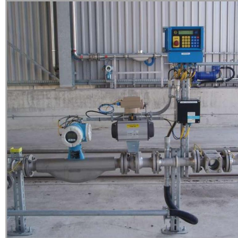
**LKW-Verladung mit dem E+H Promass und einem Kugelhahn mit pneumatischen Antrieb und 4-20 mA Stellungsregler**
